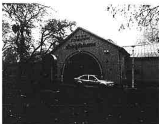
Fig. 1.7.1. Restaurantul "Privighetoarea" din Grădina Mare – Brăila (sursă: arhiva personală)
